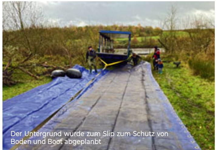
Der Untergrund wurde zum Slip zum Schutz von Boden und Boot abgeplanzt
