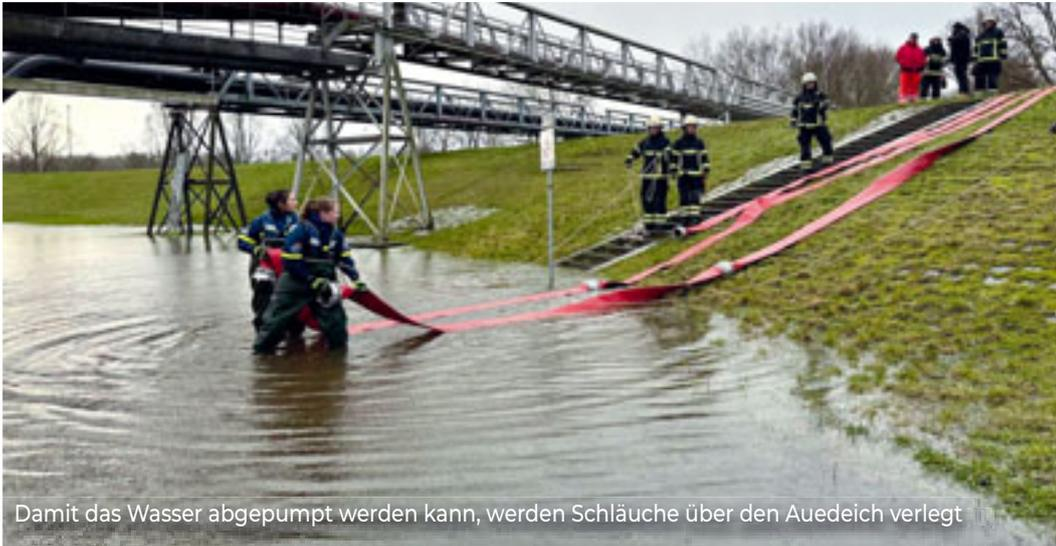
Damit das Wasser abgepumpt werden kann, werden Schläuche über den Auedeich verlegt
