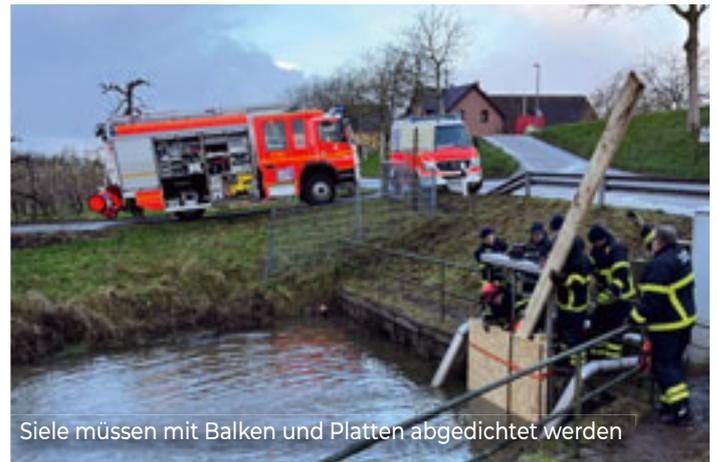
Siele müssen mit Balken und Platten abgedichtet werden
