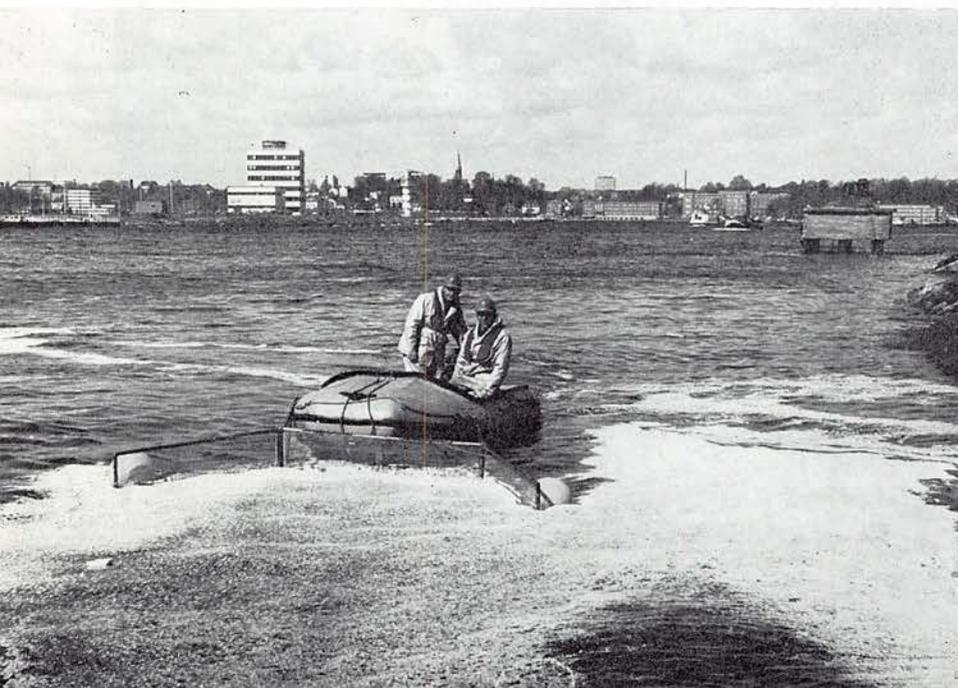
Die durch Öl verschmutzte Wasseroberfläche wird mit einem Bindemittel besprüht, damit das Öl verkrustet.
