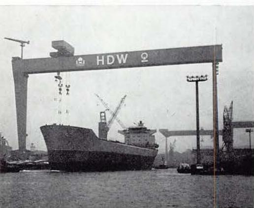
Am Tage vor dem Aufschwimmen wurde die stahlschiffbauliche Bordmontage mit ihren Außenhautarbeiten am Vorschiff nach dem Aufsetzen des oberen Bugteiles abgeschlossen.
