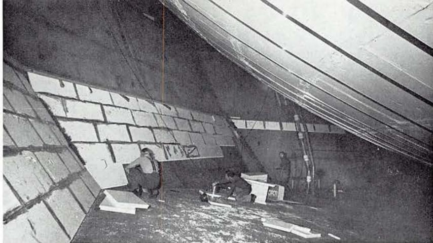
Der Void-space (Leerraum) im Doppelbodenbereich des Tanks 4 wird isoliert. Im Hintergrund: der Notentleerungsbrunnen mit Ejektor.
