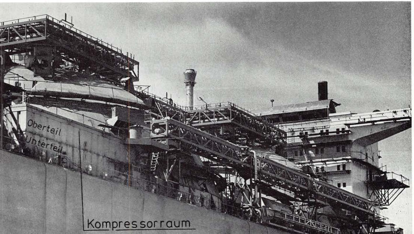
„Boil-off“, mit Hilfe des Boil-off-Kompressors (Position 2) aus den Ladetanks abgesaugt werden. Es wird mit Hilfe des Gasvorwärmers auf ca. 0 Grad Celsius aufgewärmt und der Kesselanlage zugeführt. Als „Boil-off“ wird aus wirtschaftlichen Gründen nur Naturgas gefahren.
