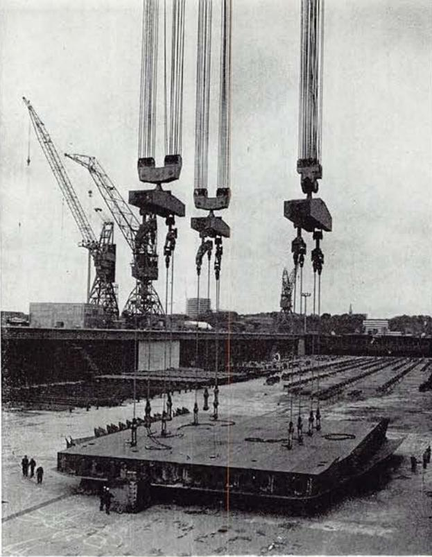
Die Kiellegung erfolgte am 18. Juni 1976 durch das Absetzen einer Doppelbodensektion.
