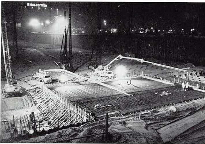
Mitte Januar 1975: Im gelenzten Dock wird das erste Feld der Docksohle betoniert.
