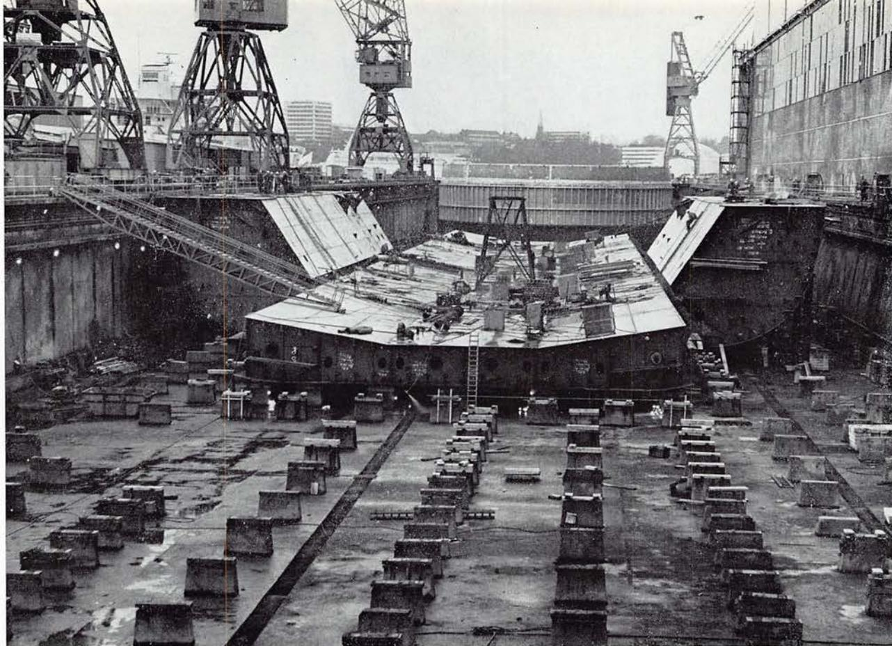
10. 1. 1976: 2568 t Schiffbaustahl sind verarbeitet. Außer den fünf Doppelbodensektionen sind je zwei Bodenseitentanksektionen des Ladetankbereiches Nr. 4 im Dock 7 abgelegt.
