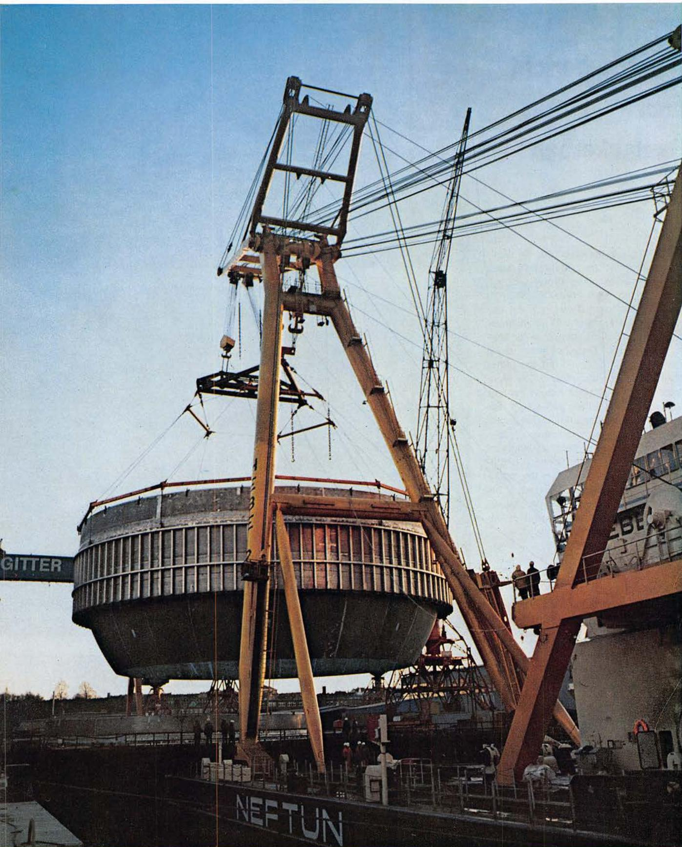
13. 12. 1975: „HEBE 2“ setzt als erste der beiden inzwischen im Werk Süd fertig montierten Kugeltank-B-Sektionen die Sektion B 5 nach viertelstündigem Transport im Dock 7 ab.
