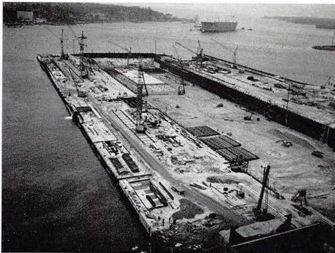
Rammen der Docksohlenpfähle folgt die Betonierung der Docksohlenfelder. Auf den Trennbauwerken werden die Kranschienen verlegt. Die Montage des 900-t-Portalkranes und dreier Drehkräne wird vorbereitet.
