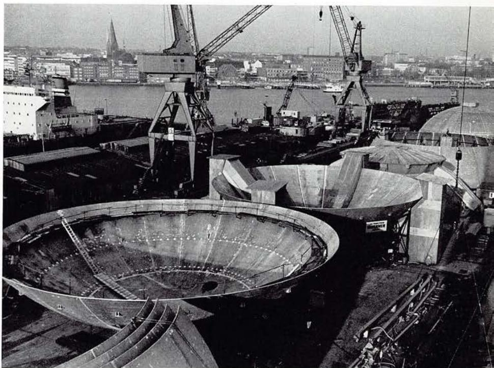
24. 11. 1975: Während auf den Bauplätzen V und VII / Werk Süd die Kugeltanksektionen B 5 und B 4 – zum Schutz der Schweißarbeiten vor Witterungseinflüssen sorgfältig abgedeckt – vormontiert werden . . .
