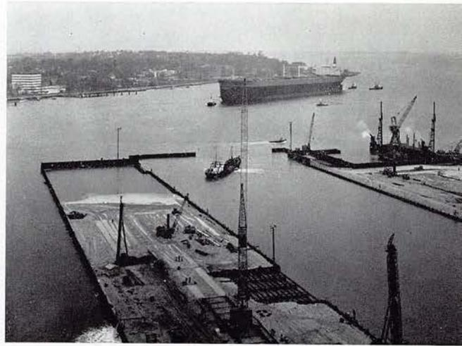
Mitte November 1974: Die Rammarbeiten der Ufer- und Dockseitenwände sind abgeschlossen. Wenig später wird die Baugrube geschlossen und zum ersten Mal gelenzt (27. 11. bis 8. 12. 1974).
