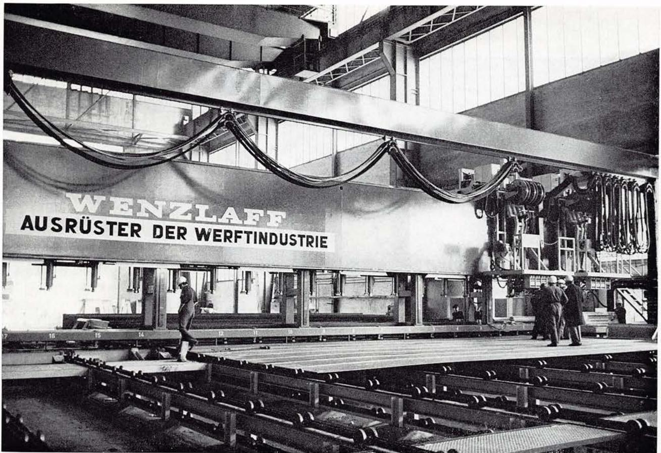
Spantenaufsetzmaschine in Halle 6/Werk Kiel-Gaarden. Probelauf am 9. Mai 1975: Die Profileinschubmaschine hat ein Profil unter die Aufsetzmaschine „geschossen“. Noch wird es durch den der Führung dienenden Klemmbalken verdeckt.
