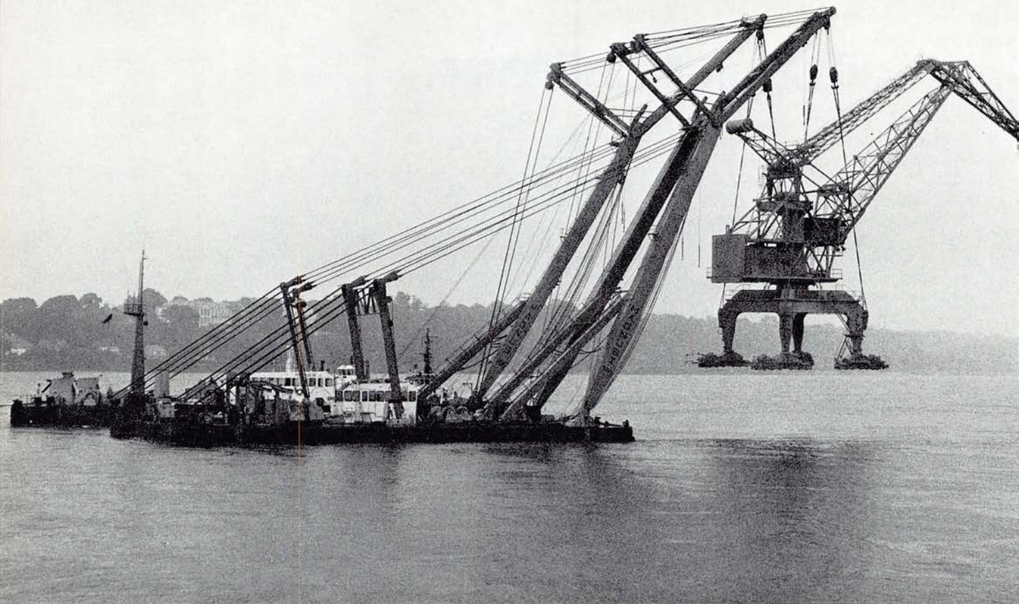
Oben: „MAGNUS I“ und „MAGNUS II“ packen den 45-t-Kran von Werk Finkenwerder und bringen ihn zu dem 1000-t-Schwimmkran „MAGNUS X“ für den Transport durch den Nordostseekanal. Unten links: In Kiel
