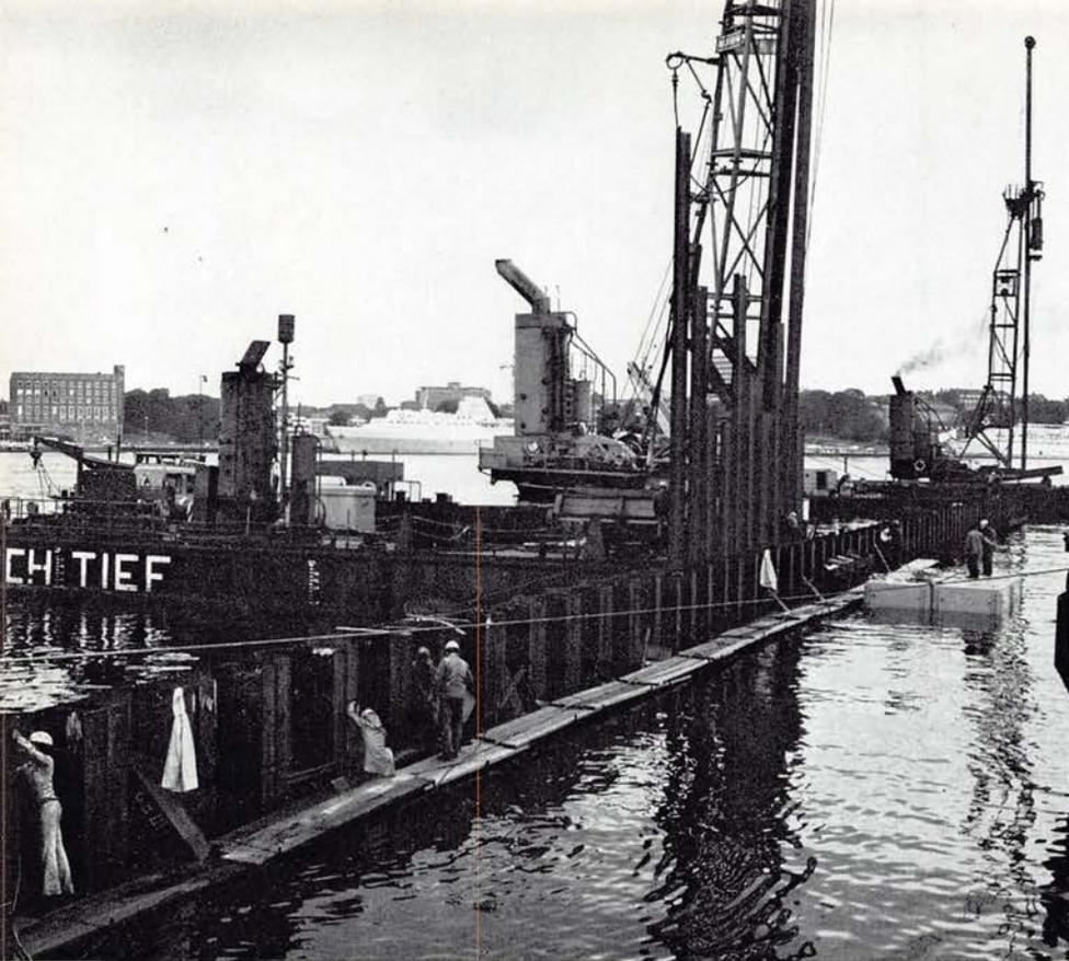
oben: Zwei Rammen arbeiten hintereinander im Takt. Unmittelbar nach der Rammung beginnen die Arbeiten zum Anschluß der Schrägpfähle an die Tragbohlen.
