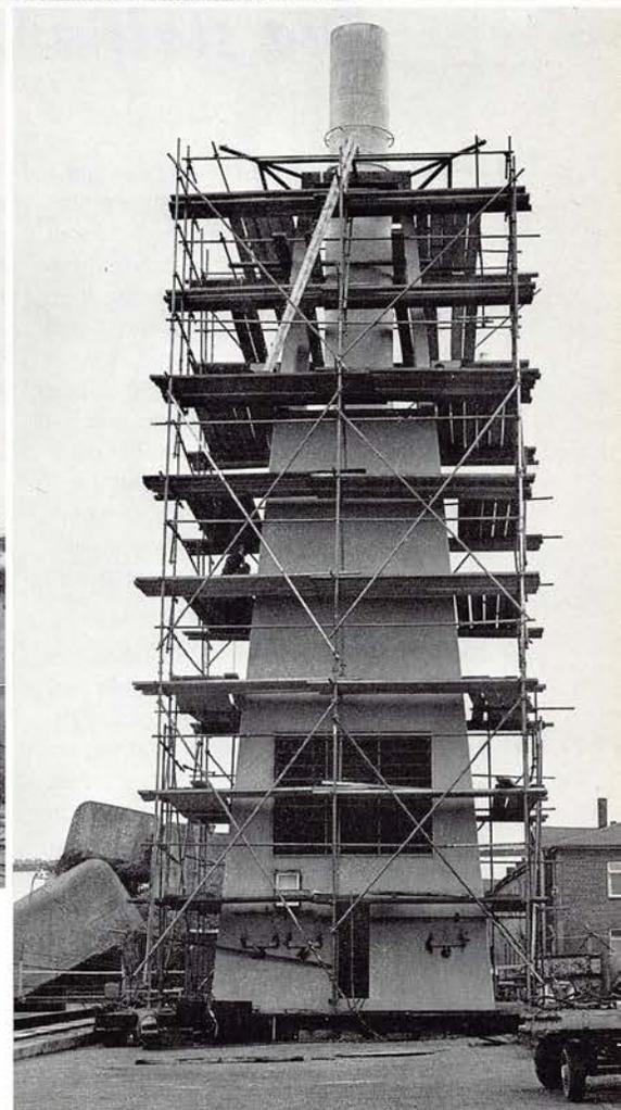
Während Hintersteven und Hecksektionen montiert werden, entstehen bereits Aufbauten und Schornstein.
