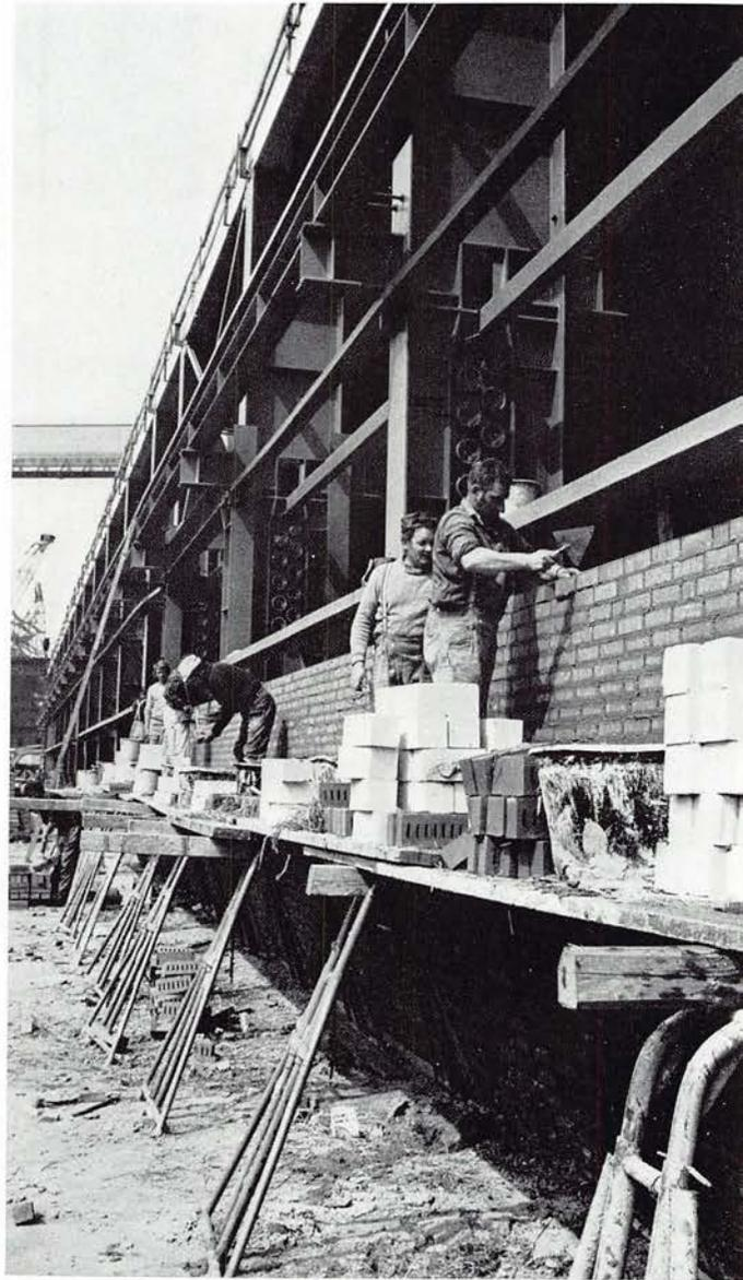
Die Außenwände der Rohrwerkstatt bestehen aus Stahlfachwerk, das im unteren Bereich ausgemauert und im oberen Bereich verblecht wird.
