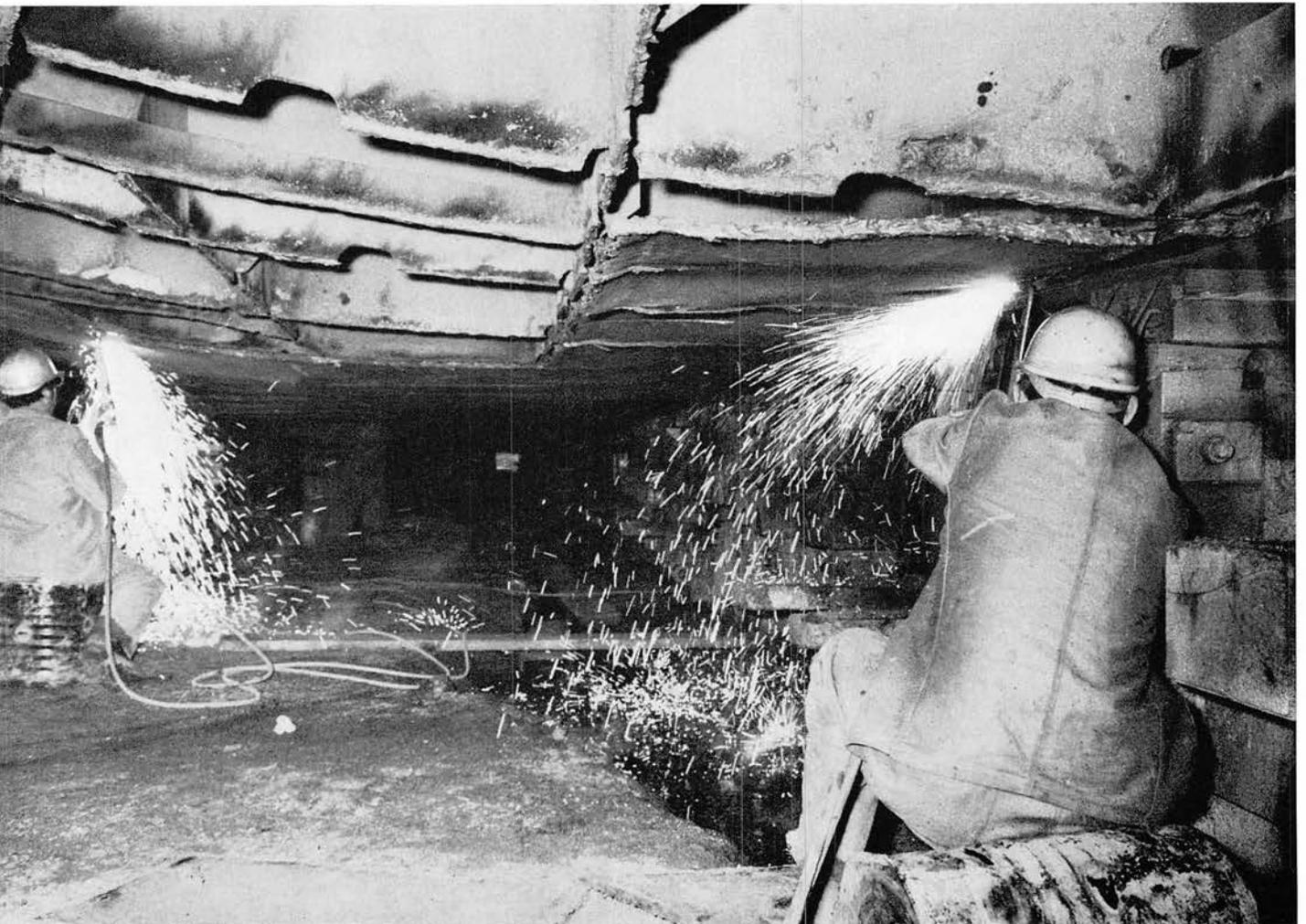
ten mit weißer Markierungsfarbe anzuzeichnen. Kurz darauf machen sich die Brenner ans Werk. Der Brennstrahl frißt sich zischend durch die etwa 2 cm starken Bleche, Funken sprühen, aus dem Doppelboden spritzt schlammiges Wasser.
