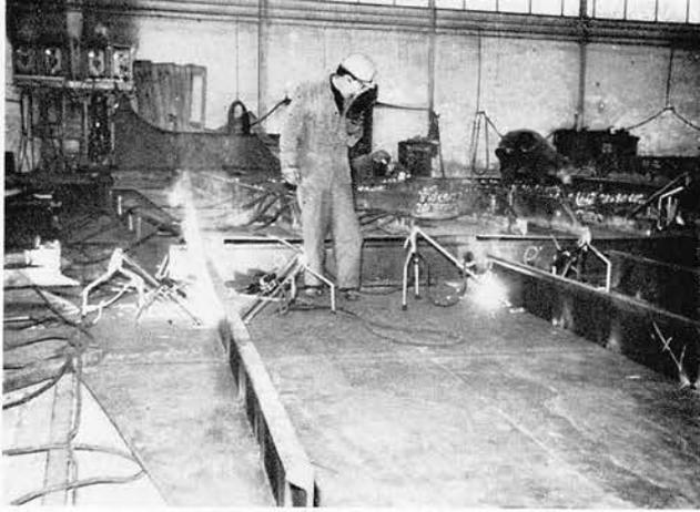
Heute werden an diesen Geräten 700 bis 1000 mm lange Elektroden bei 90 bis 100 V Gleich- oder Wechselstrom verschweißt. Die besten Ergebnisse werden bei Wechselstrom erzielt, da dann die Blaswirkung wegfällt.
