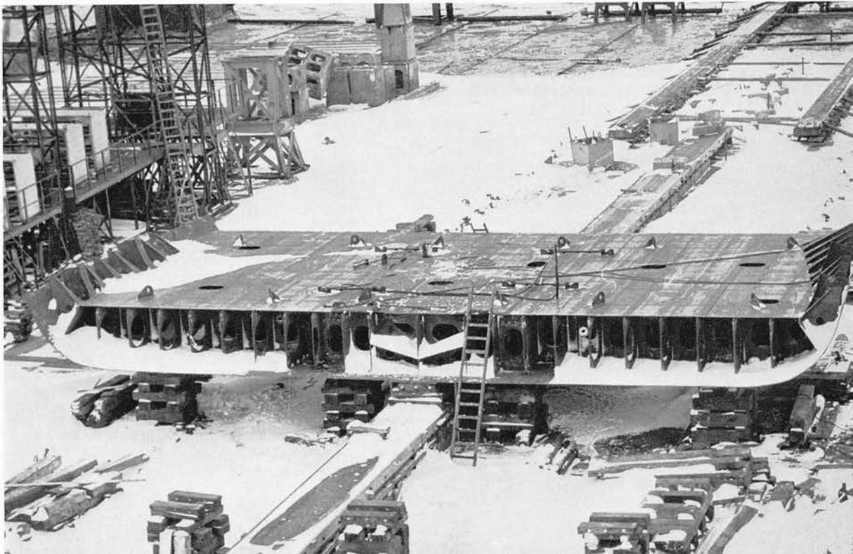
Gleich nach Ablauf der „Tugeland“ wurde ein neues Schiff auf Kiel gelegt: das 6000 tdw Kühl-Motorschiff S. 813 für die Reederei Laeisz.
