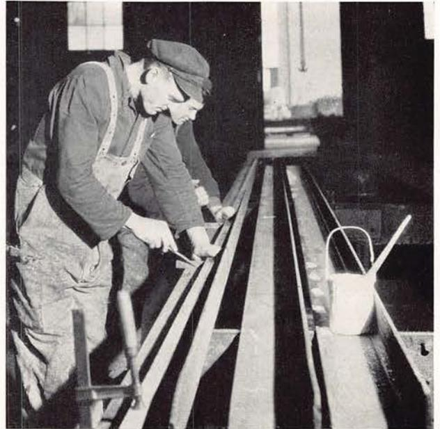
Schiffbauer Walter Wendt und Schiffbauhelfer Eugen Zinsel zeichnen nach einer Latte Decksbalken an.
