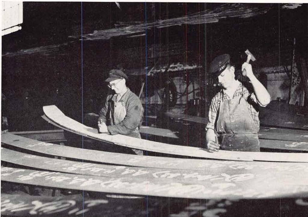
Schiffbauer Arnold Loges und Schiffbauhelfer Manfred Hecht zeichnen nach den von dem Schnürboden angefertigten Spantmodellen die gebogenen Spanten an.
