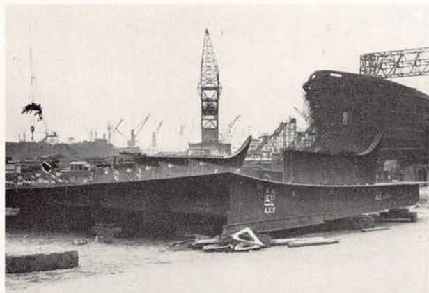
Eine Außenhautsektion wird auf einer Hilfsschale alter Art montiert
