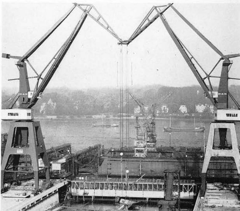
Helgen die Hauptmaschinenanlage weitgehend eingebaut werden kann. Die praktisch unbeschränkte Bauhöhe auf dem Helgen läßt die vollständige schiffbauliche Fertigstellung der Aufbauten zu, so daß nach dem Stapellauf die Ausrüstungsbetriebe ihre Arbeiten in vollem Umfang am Ausrüstungskai beginnen können.
