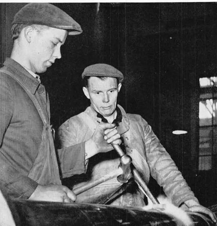
mehr aus. Wir sind deshalb dazu übergegangen, die Rohre maschinell zu biegen. In den Rohrbiegemaschinen können Rohre bis zu 200 mm  $\phi$  über Dornwerkzeuge hohl und kalt gebogen werden. Man spart auf diese Weise das Füllen und Wärmen und gewinnt sehr viel Zeit.
