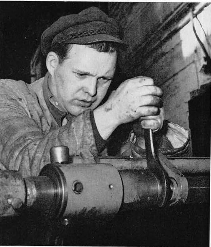
Maschinenarbeiter Hans Baedtker beim Einstellen des Dornes der Rohrbiegemaschine
