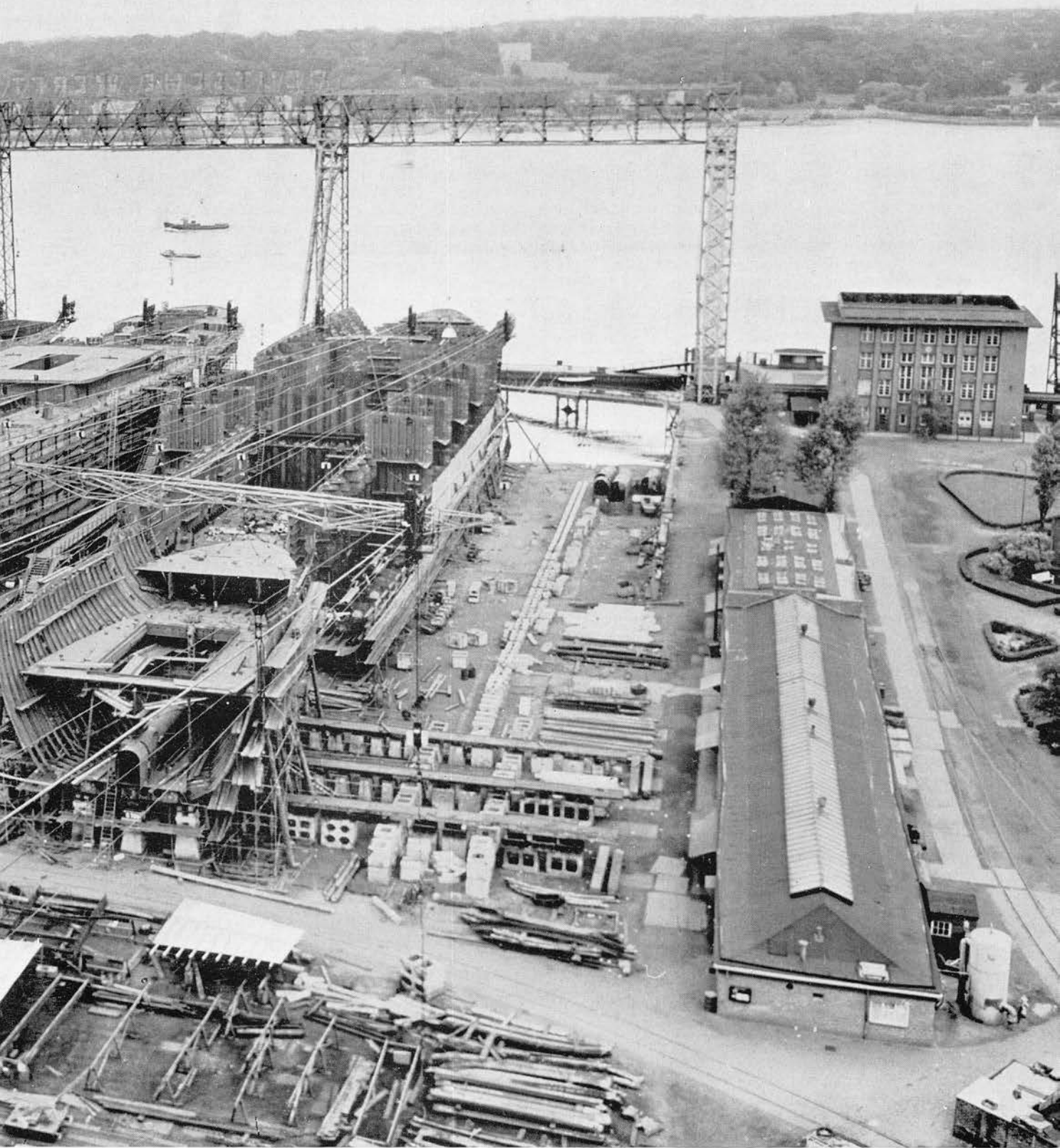
Unsere Helgenanlage aus der Vogelperspektive mit sieben im Bau befindlichen Schiffen. Von links nach rechts: S 723 (inzwischen abgelaufen); Vorschiff von S 715 und S 730 (Boden-sektion); S 710; S 721; S 716 (Hinterschiff) und davor die hinterste Abschnittssection von S 724.
