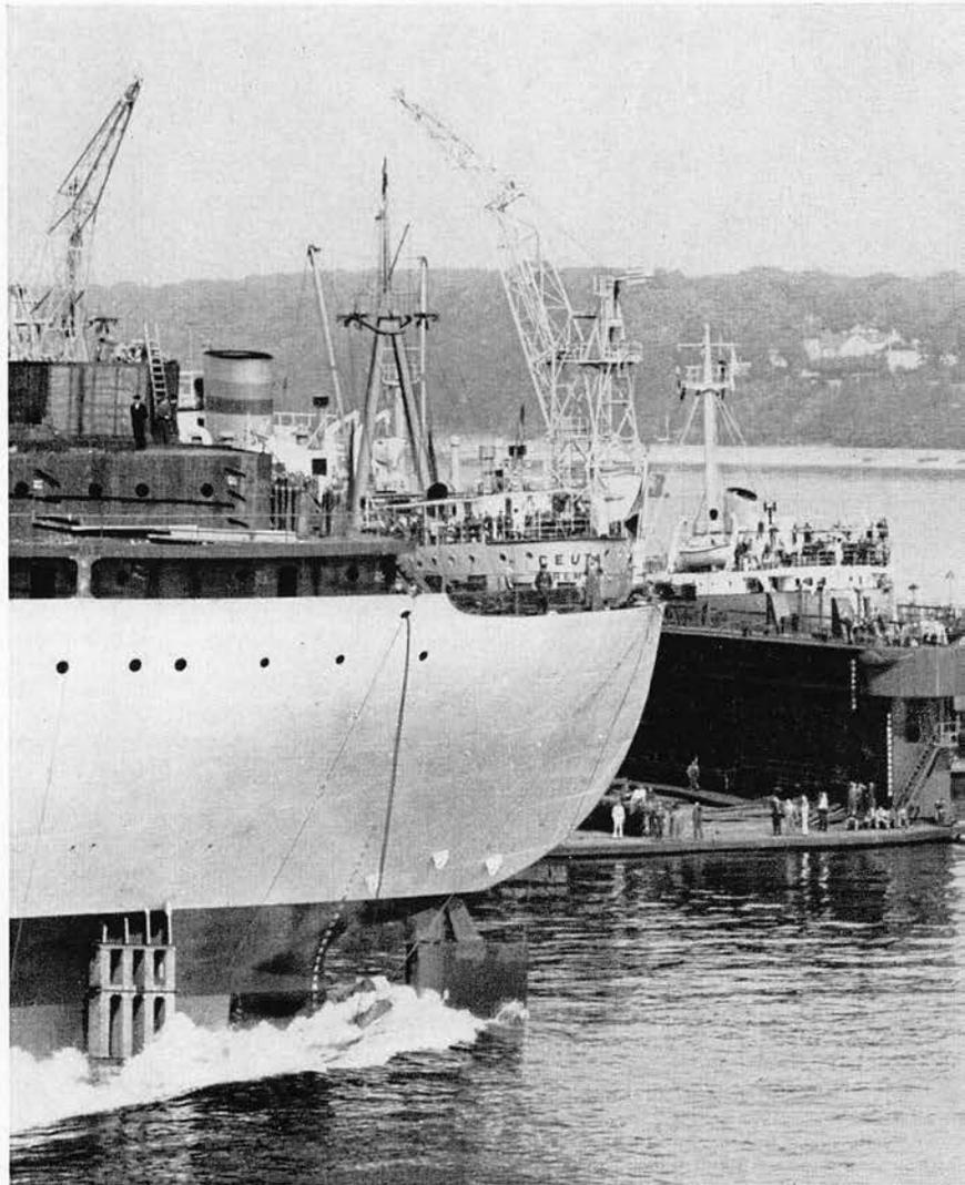
*Hinterschiff Bau-Nr. 715 läuft vom Stapel*
