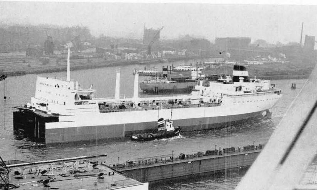
Schiffbau in Teilen
