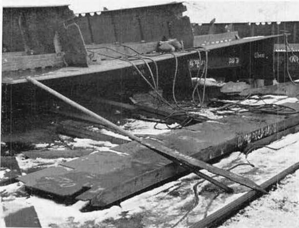
Bild 20: Lose aufgelegte Eisenrückleiter ergeben schlechte Schweißung
