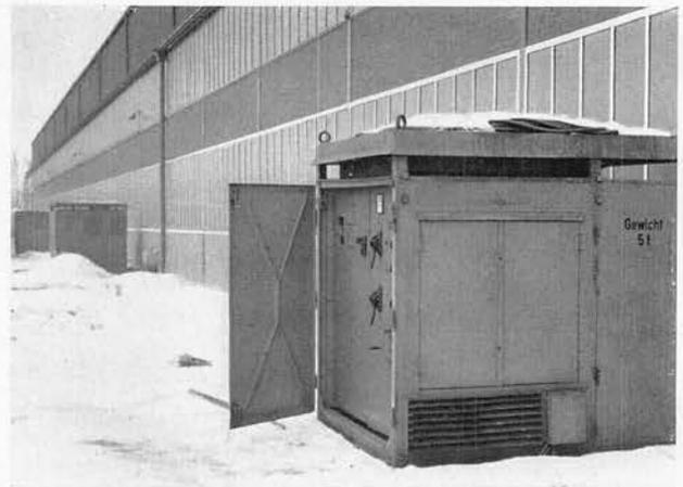
Bild 14: Drei parallelgeschaltete Schweißgleichrichter an unserer Schweißhalle
