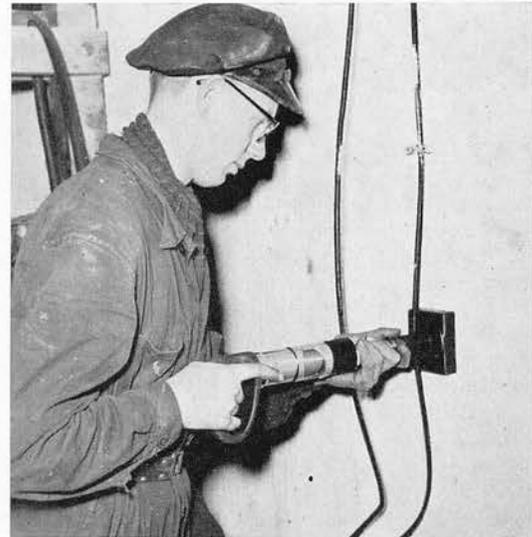
*Gewindebolzen für Schellenhalterungen werden in Beton eingeschossen*
