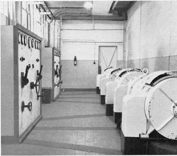
Bild 3: Umformzentrale der Großschweißerei
