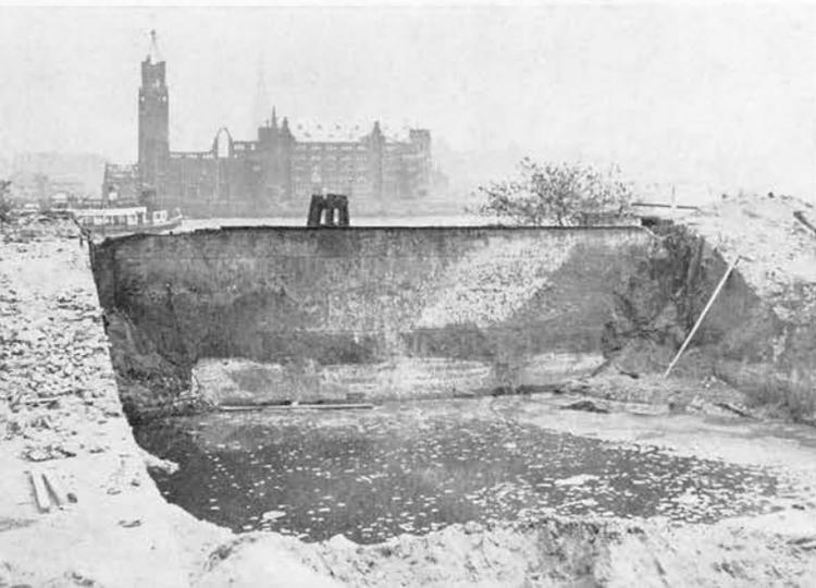
Abräumung des Vorgeländes von den alten Bauwerksresten. Pfahl an Pfahl in Beton und Holz und tiefe Gründungen für das ehemalige L-Dock stellten ungeheure Anforderungen an Mensch und Maschine. Ständig stand man vor neuen Überraschungen. Greifer, Bagger, Schwimmkräne und Taucher mit Sprengladungen waren unermüdlich Tag und Nacht im Einsatz, aus diesem Ruinenfeld eine langsam wachsende Kaimauer mit einer Wassertiefe von 8 m zu erstellen.
