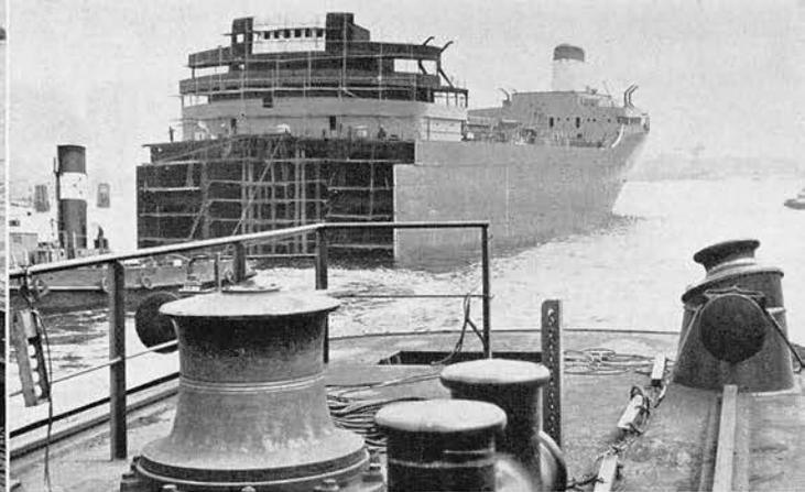
Die Bauteile der „Cabimas“ werden ins Dock geschleppt
