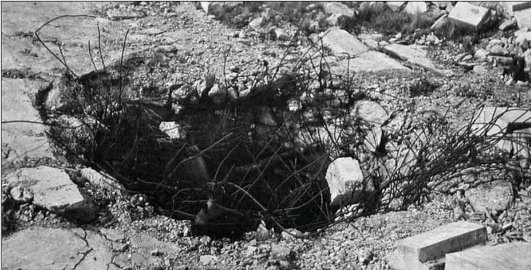
Am 9. April 1945 wurde der Bunker von 6 Spezialbomben getroffen. Hier ein Durchschlag in der 3,5m dicken Betondecke.
