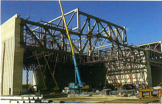
*Die A380-Ausstattungshalle im Mühlenberger Loch nimmt Gestalt an. Jetzt wird am Außenfachwerk gearbeitet, an dem im April das Hallendach aufgehängt werden soll. Am 23. Februar hievten zwei Mobilkräne den ersten Laufträger in die Höhe.*
