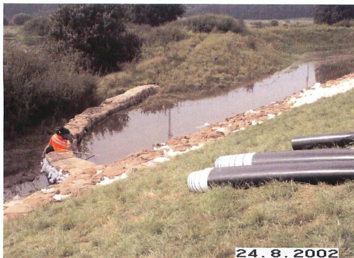
Im Laufe des Einsatz vermehrten sich die Leckstellen im Deich. Feuerwehr, Bundeswehr und THW hatten allerhand zu tun, diese Stellen mittels Sandsäcken zu sichern.
