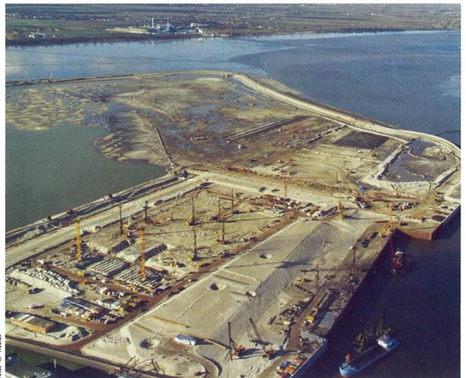
Im Vordergrund die Teilfläche 1 mit der Pfahlgründung für die spätere Sektionshalle. Nach oben anschließend die Teilflächen 2 und 3. Die „Einkerbung“ im Vordergrund gehört zur künftigen Kaianlage. Aufnahme: Februar 2002
