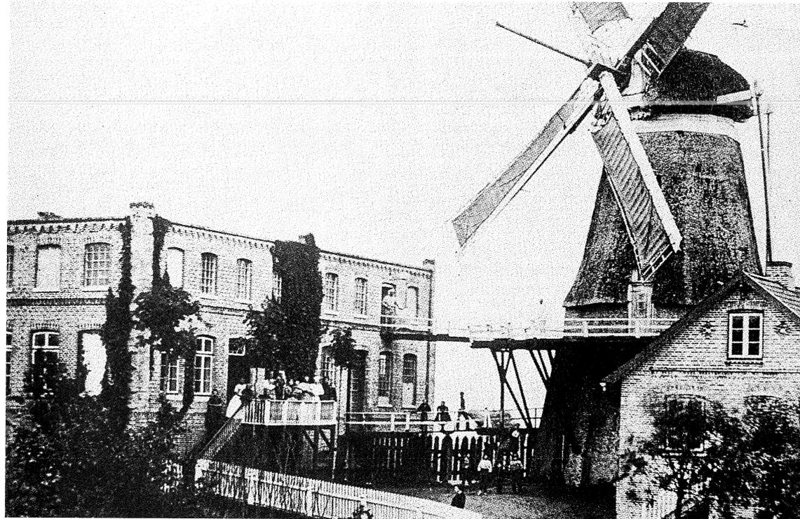
Die erste Finkenwerder Windmühle von 1816, noch mit »Steert« zum Drehen »in den Wind«.
